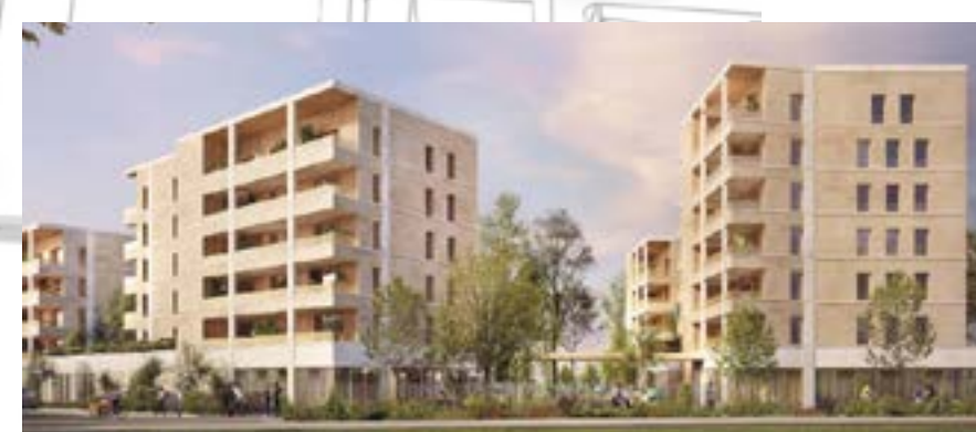
S1 et S2 • BATI-LYON / Atelier Régis Gachon architecte
