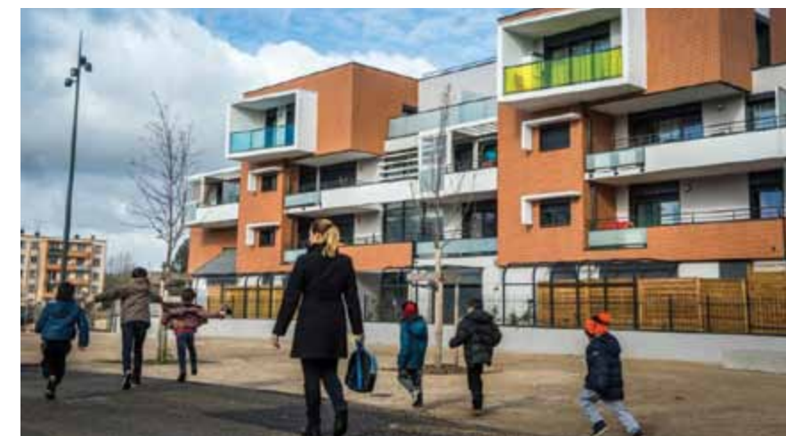
Grappinière : nouvel immeuble proposant des logements privés
