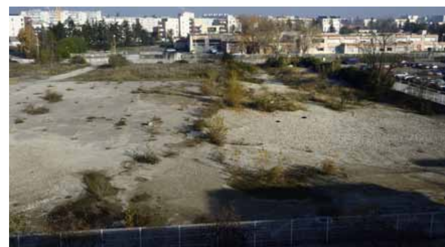
ZAC Hôtel de Ville : urbaniser le secteur libéré par la démolition du centre commercial du Grand Vire
