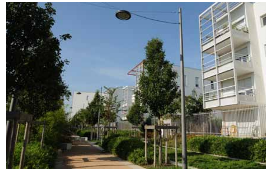
Au centre ville : Une noue permet d'infiltrer les eaux pluviales et participe à la végétalisation de l'espace public.
