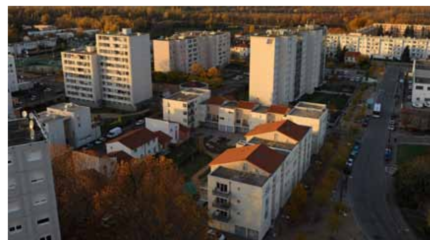
Construction de logements aux Grolières
