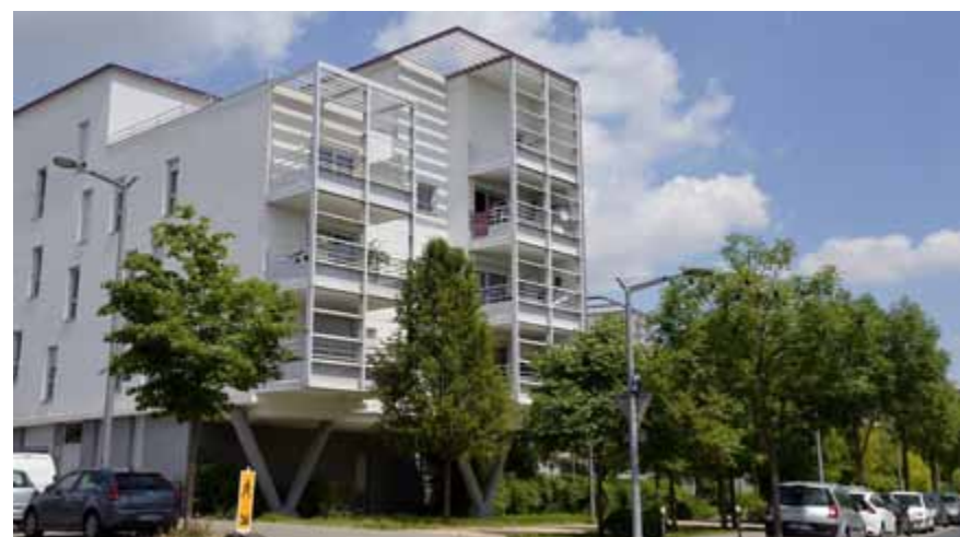
Nouvelle rue, nouvelle construction au centre ville
