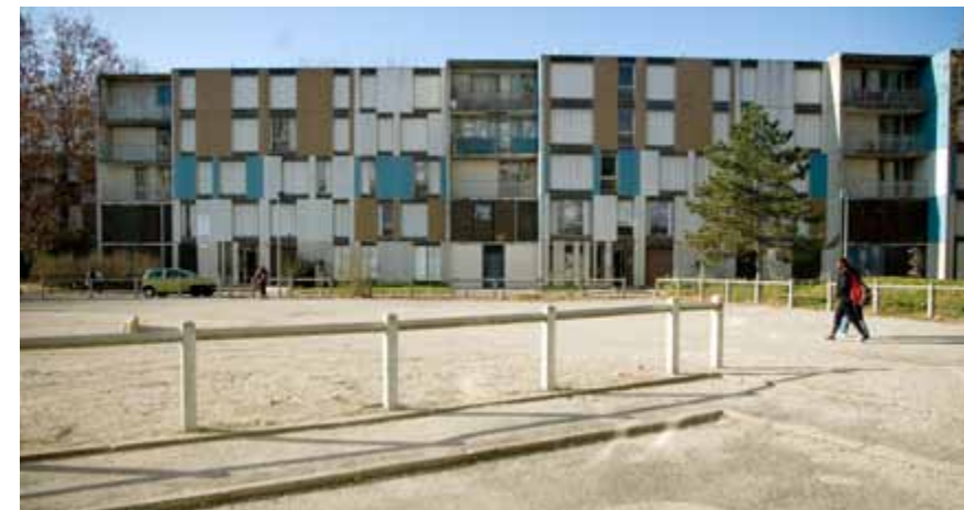
Un bâti énérgivore, qui s'est rapidement dégradé et qui a perdu en attractivité (25% de logements inoccupés dans certains quartiers)
