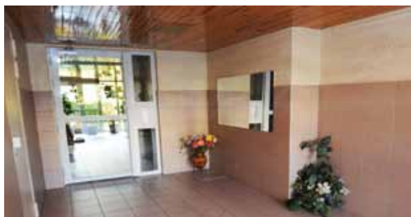
Résidence «Les Trois Mâts», hall et montée d'escalier après travaux
